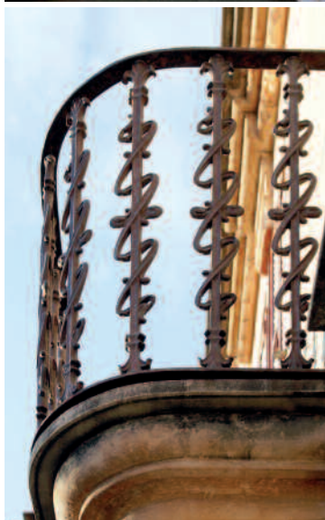
Detalle de las barandillas en los balcones del Hotel Cosmopolita, idénticas a las de la casa del c/. de Mallorca.
